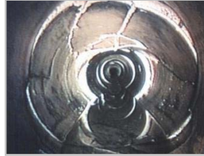
下水道管の再整備 (管更生工法)
